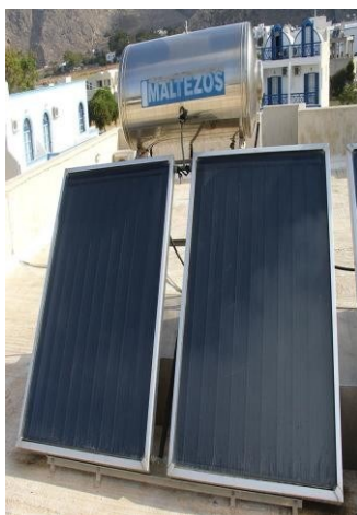
Rys. 8. Kolektor płaski ze zbiornikiem do ciepłej wody (a); kolektor próżniowy ze zwierciadłem doświetlającym (b)
