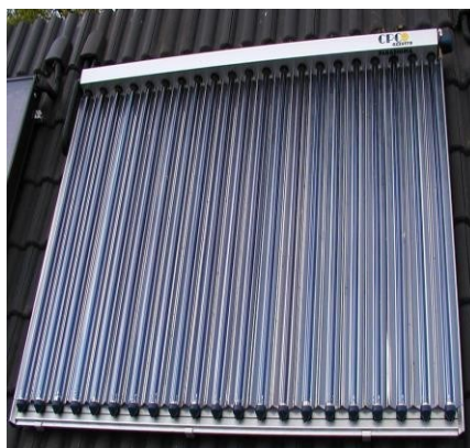
Rys. 8. Kolektor płaski ze zbiornikiem do ciepłej wody (a); kolektor próżniowy ze zwierciadłem doświetlającym (b)
